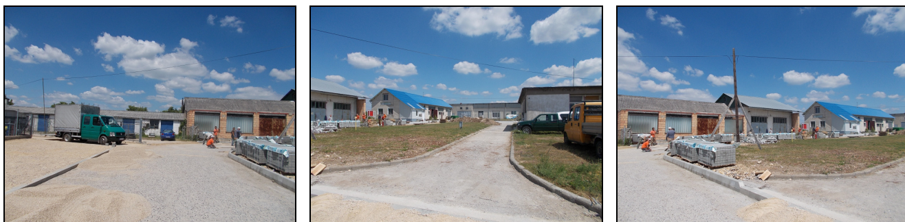
A 69/12 hrsz-ú teresedés (burkolás közben) (25-27)
